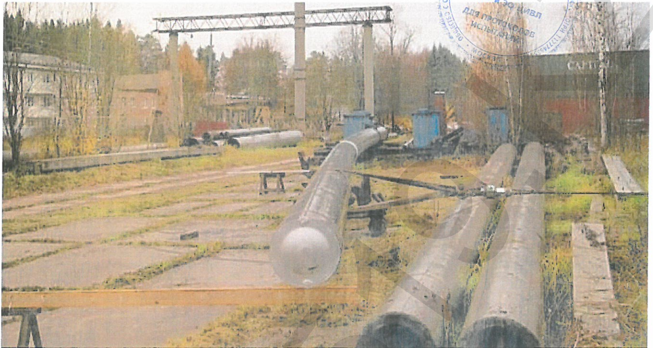
Рисунок 5 – Испытания сборной железобетонной стойки СК 26.1-2.3 Сб
