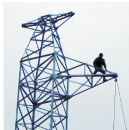
В горных условиях в скальных грунтах проложено более 35 км подъездных технологических дорог. Наличие пролетов с большой протяженностью от основания до верха перевалов потребовало применения усиленных опор У-330-3+14 с 14-метровыми подставками, монтаж которых осложнялся стесненными условиями – ограниченными по размеру площадками.
